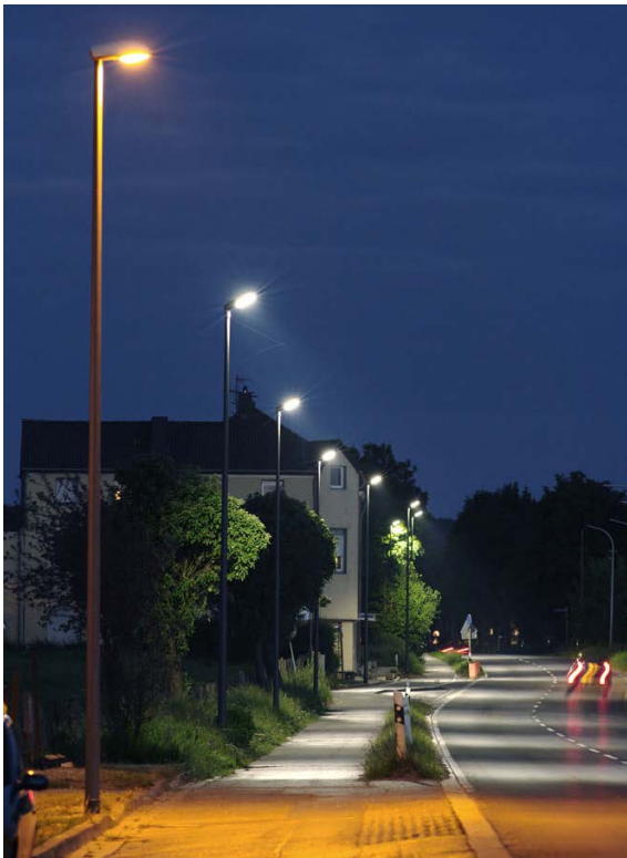
Linkes Bild: Hocheffiziente Ausleuchtung von Straßen mithilfe der OPTILIGHT-Leuchten (erste Leuchte ist alt, restliche sind neu). Rechtes Bild: OPTILIGHT-Optiken im Detail, Quellen: STAWAG AG, Innolite GmbH
